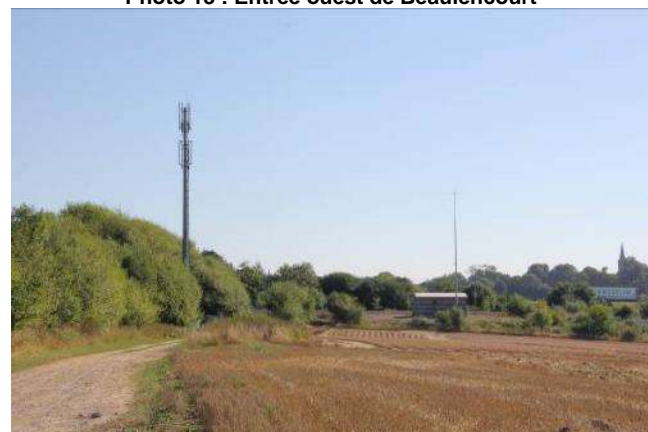
Photo 15 : Pylône Orange et local RFF
