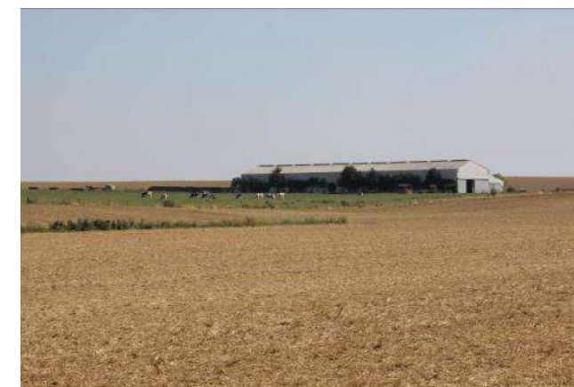
Photo 17 : Hangar agricole à l'entrée de Gueudecourt
