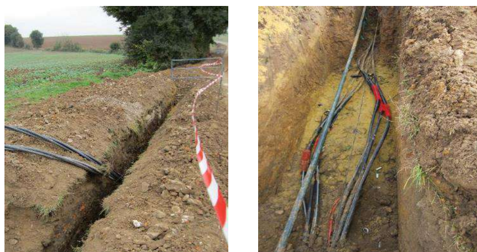
Photo 22 : Exemples de tranchées
