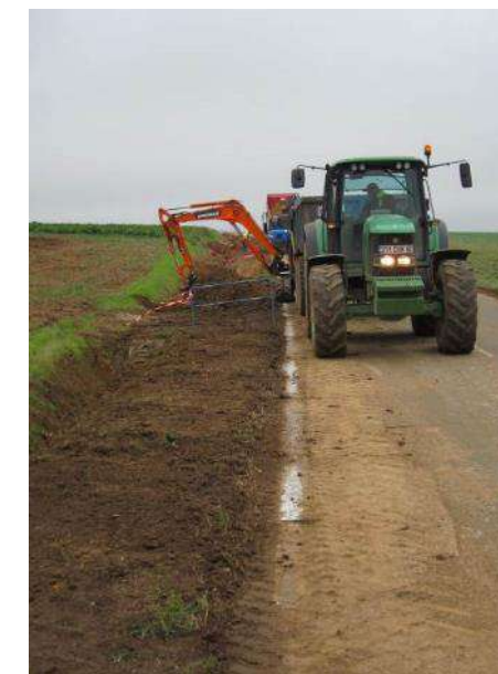
Photo 23 : Exemple de tranchée
