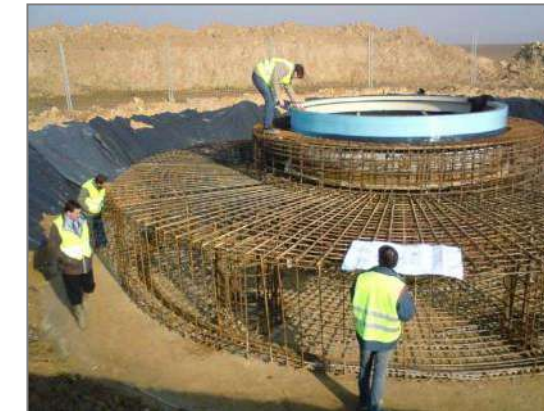
Photo 4 : Ferrailage d'un massif – parc éolien de Saint-Léger (Source : EUROWATT)
