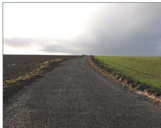
Photo 2 : Rénovation d'un chemin d'accès Source : EUROWATT
