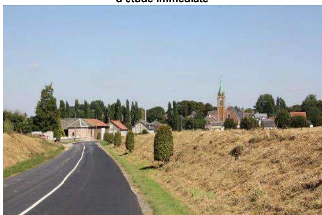
Photo 12 : Entrée ouest du village de Le Transloy
