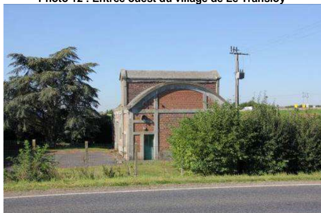
Photo 14 : Station de pompage de Riencourt-lès-Bapaume
