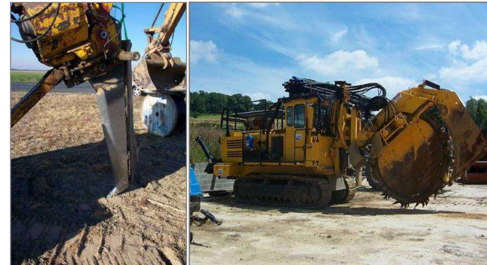
Photo 6 : Enfouissement des câbles par soc vibrant (gauche) ou trancheuse (droite) (Source : EUROWATT)
